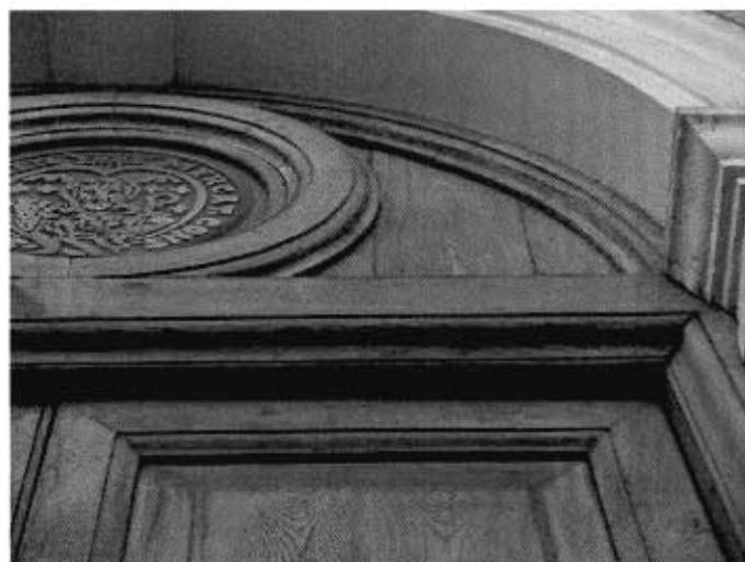
La CENTINA con rosone in vetro serigrafato e cornice in legno presenta in modo abbastanza omogeneo delle FENDITURE nel giunto dei pannelli utilizzati per la costruzione. La causa consiste nella disidratazione del legno con conseguente ritiro del materiale originario.
