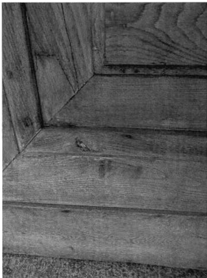
fig. 1 Presenza di FESSURAZIONI da giunzione e venatura del legno, causate dalla disidratazione con conseguente ritiro del materiale originario con CRETTATURA dello stucco di colore grigio. OSSIDAZIONE dei chiodi utilizzati per il montaggio. PATINA GIALLA, probabilmente trattasi di un fissatore protettivo (vernice) ossidato e quindi cristallizzato.
