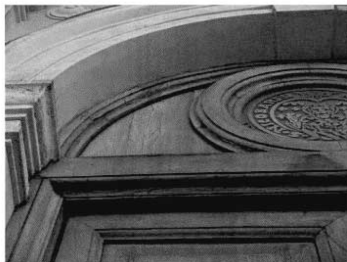
La CENTINA con rosone in vetro serigrafato e cornice in legno presenta in modo abbastanza omogeneo delle FENDITURE nel giunto dei pannelli utilizzati per la costruzione. La causa consiste nella disidratazione del legno con conseguente ritiro del materiale originario.
