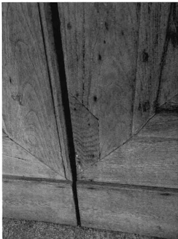
fig. 1 Presenza di FESSURAZIONI da giunzione e venatura del legno, causate dalla disidratazione con conseguente ritiro del materiale originario con CRETTATURA dello stucco di colore grigio. OSSIDAZIONE dei chiodi utilizzati per il montaggio. PATINA GIALLA, probabilmente trattasi di un fissatore protettivo (vernice) ossidato e quindi cristallizzato.
