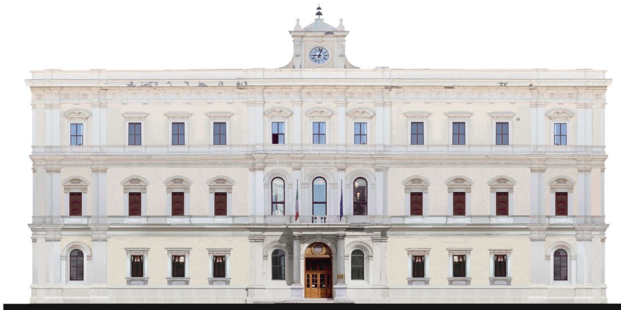
[Restituzione fotografica del prospetto principale su Corso Cavour]
